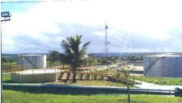
Figura 8 - Tanques de armazenamento de petróleo tratado e especificado
