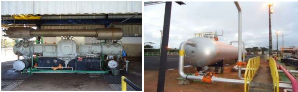
Figura 11 - Compressor de gás natural e vasão separador de gás e condensado (SD)
